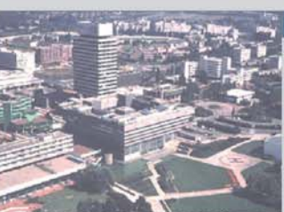
6- CENTRE DE CERGY, PRÉFECTURE, arch. : H. BERNARD 7- EVRY, PLACE DES TERRASSES DE L'AGORA, arch. : A. CATTANI, V. FABRE, J. PERROTET
