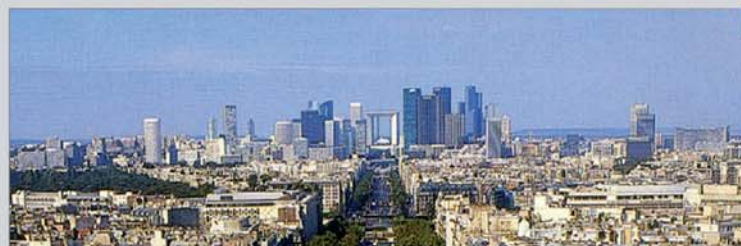
11- HALLE DE SAINT-QUENTIN-EN-YVELINES, arch. : P. et M. DESLANDES 12- QUARTIER DE LA DÉFENSE (BUREAUX) 13- CENTRE COMMERCIAL DU VAL D'EUROPE (COMMERCES), arch. : Agence LOBJOYE 14- STADE DE FRANCE, SEINE-SAINT-DENIS, arch. : M. MACARY, A. ZUBLENA, M. REGEMBAL, C. COSTANTINI
